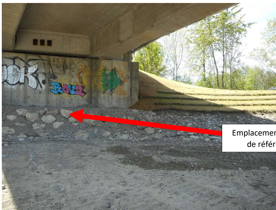
Figure 10 : Vue sous le pont de la RD1005 (vers l'amont).
