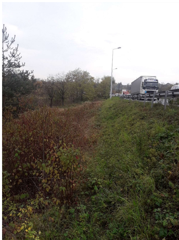
Vue du remblai
