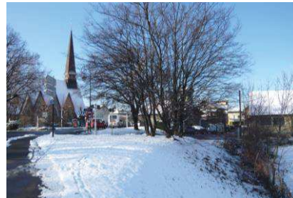
Talus en bordure du chemin Ballastière
