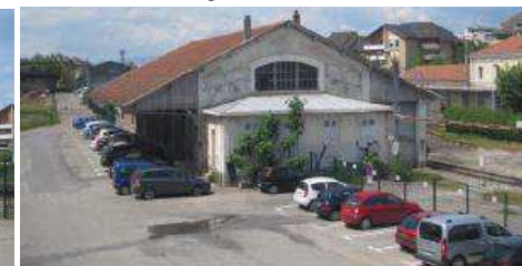
Parking-relais provisoire au sud des voies ferrées
