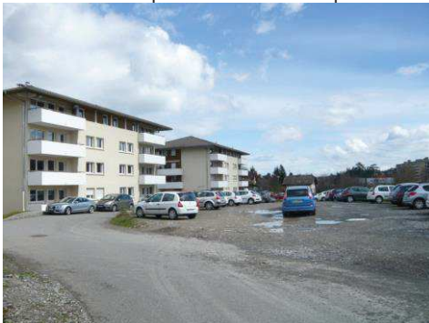
Stationnement non encadré sur le haut du secteur devant les bâtiments "Androsace"
