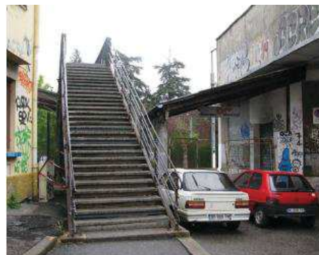
Débouché de la passerelle existante traversant les voies, impasse de la Passerelle
