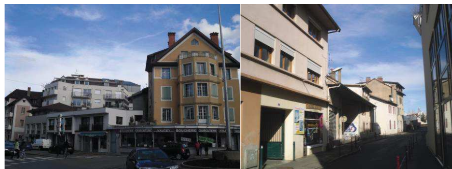
Tissu bâti mixte le long de l'avenue Jules Ferry
