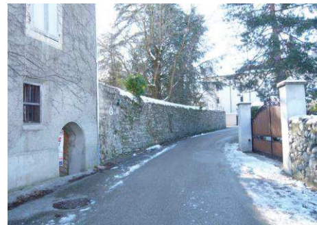
Mur maison forte de la Fléchère, en limite de la voie
