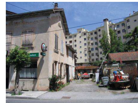
Bâtiment dégradé situé rue de l'Industrie
