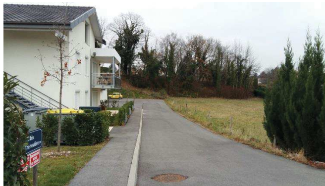
Talus au nord et future voie d'accès à l'avenue de Ripaille
