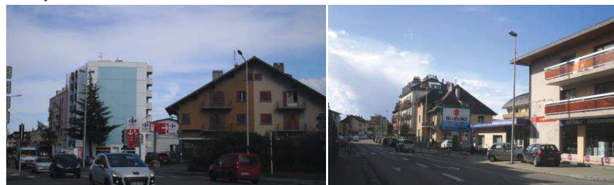
Futur carrefour d'accès à la voie de franchissement (avenue Jules Ferry)
