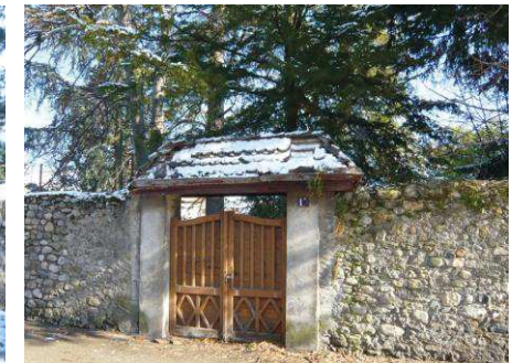
Accès piétons sur chemin de la Fléchère
