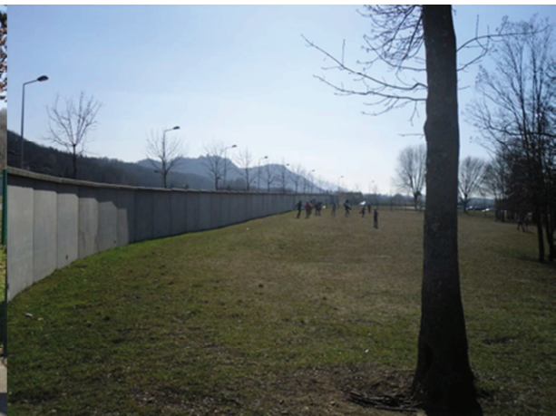
Vue du mur depuis cour école primaire
