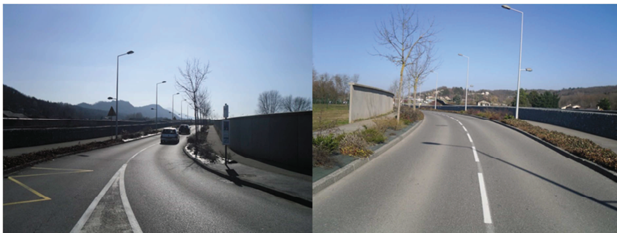
Vue du mur depuis le chemin du Morillon / rocade en contrebas du mur en gabions
