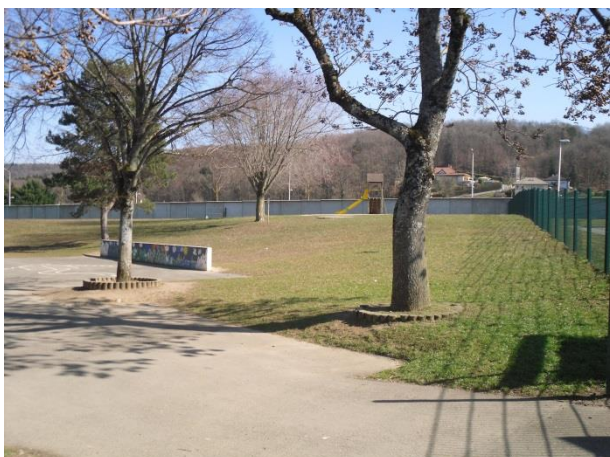
Vue du mur depuis cour école maternelle
