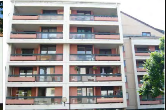
Alternance des vides et des pleins dans le traitement du garde-corps des balcons
