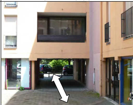
PASSAGES PIETONS SOUS IMMEUBLE
