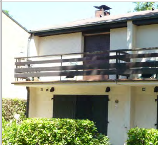
Balcon à 3 lisses et main courante, en bois brun foncé
