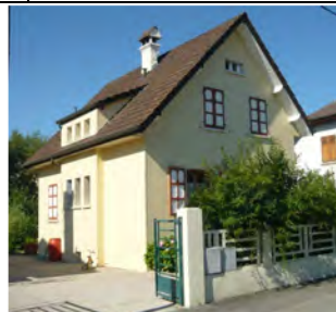
N°10 Niveau de protection contrôlée
