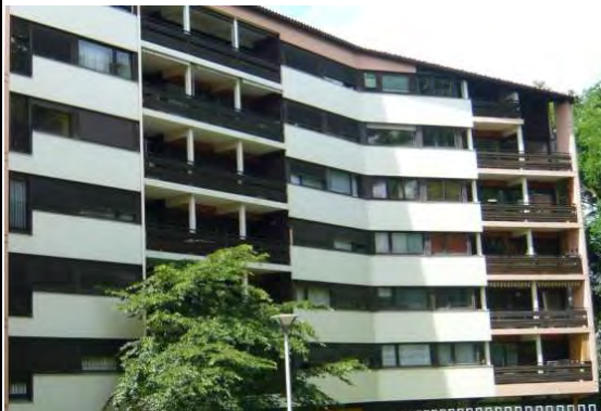
Balcons creusés dans la façade de teinte sombre en opposition avec le nu du mur de la façade de couleur claire. Les balcons sont découpés en travée.
