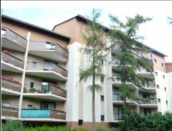
Balcons saillants avec alternance de garde-corps pleins et garde-corps transparents
