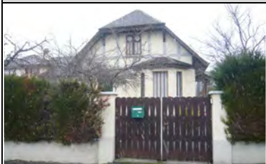
N°1 VILLA 1937 oriel à 3 pans Niveau de protection contrôlée
