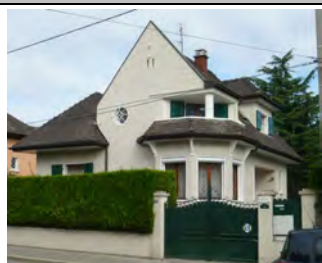
N°21 – VILLA M. Paul GAILLARD 1931 HENRI BESSON ARCHITECTE Protection stricte
