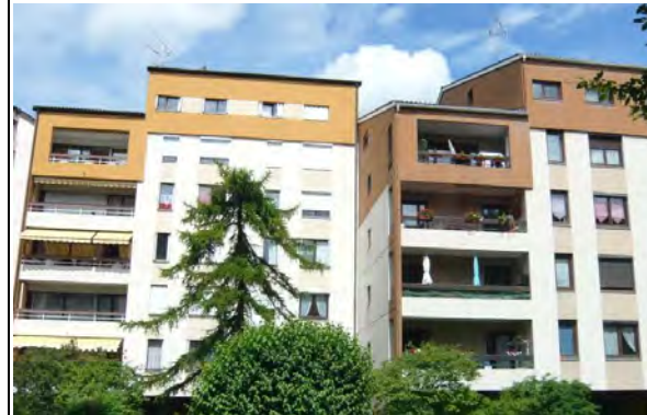
Une travée entière de balcon pour marquer l'horizontalité
