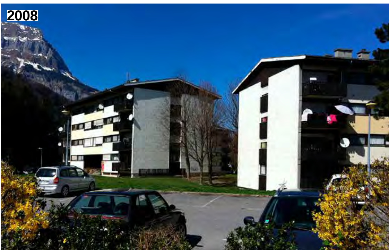
Cité Vouilloux, Sallanches, après rénovation thermique en 2008
