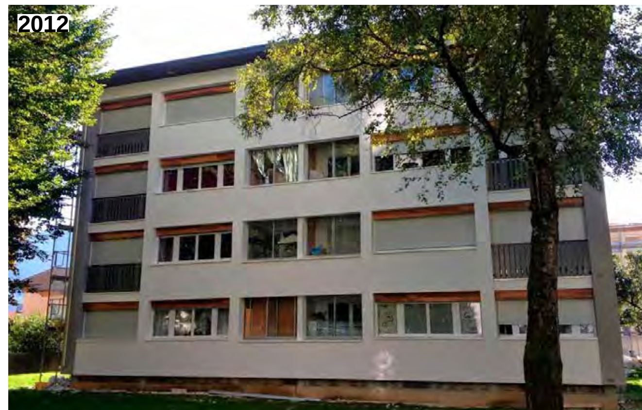
Quartier Novel, Annecy, après rénovation thermique de Catherine Boidevaix architecte et Silo architectes en 2012
