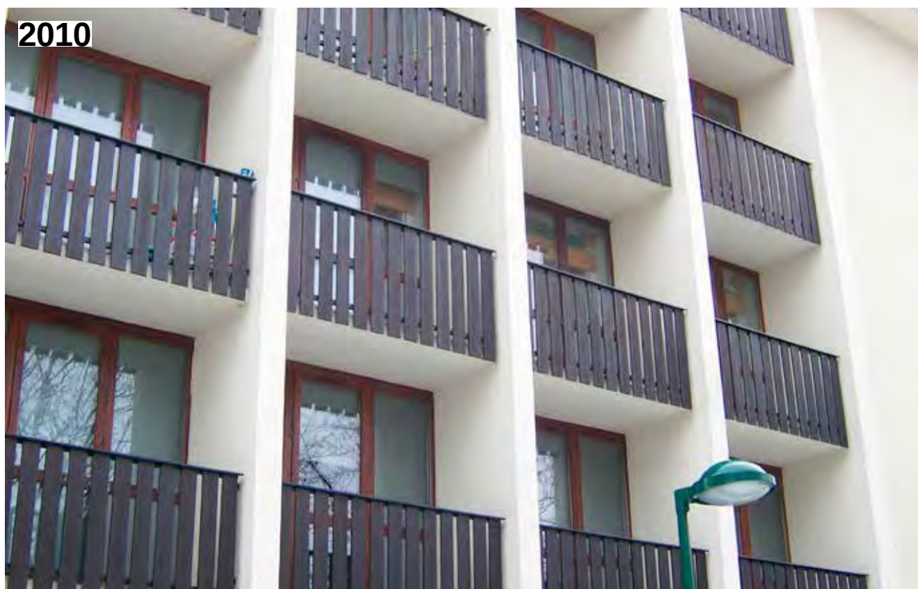
Ensemble de logements, Le Village Olympique, Grenoble, en 2010 après rénovation thermique
