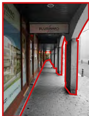
Galerie commerciale abritée
