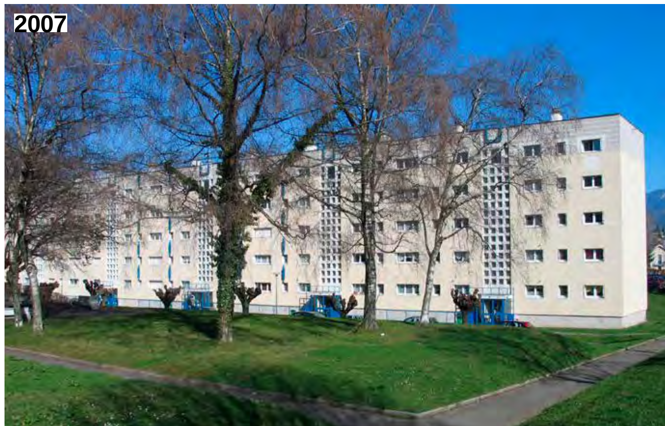
Ensemble de logements, Le Biollay, Chambéry, après rénovation thermique en 2007
