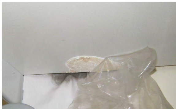
Bouche d'extraction de ventilation colmatée Plafond cloqué
