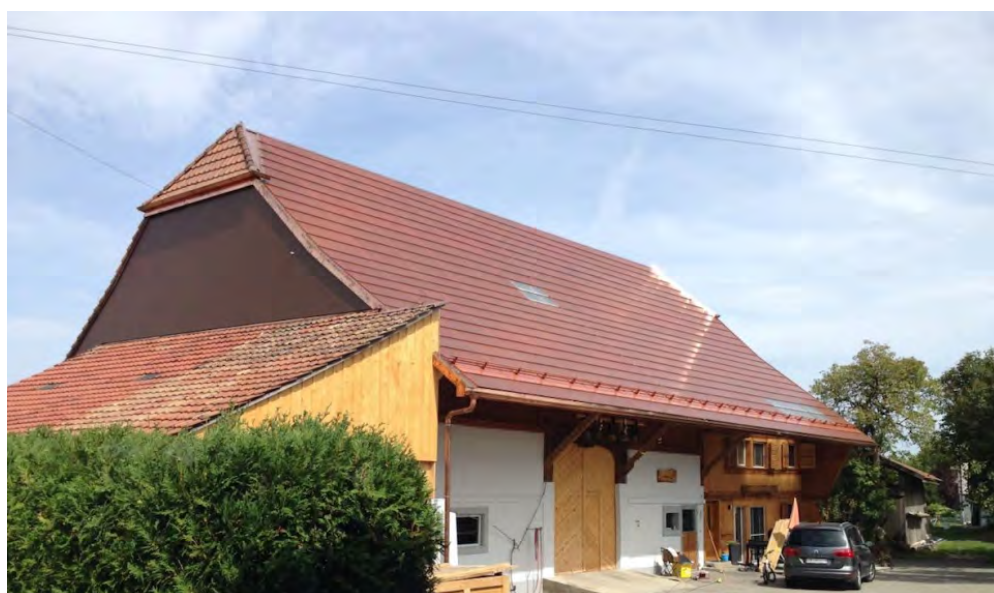
Exemple de toiture avec une solution ISSOL Solar-Terra (source Issol http://www.issol.eu/fr/solarterra-fr/ )
