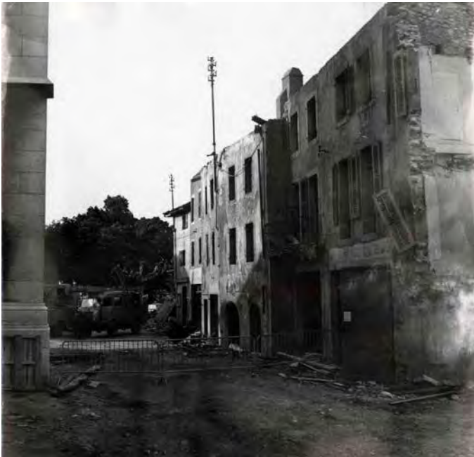
Les démolitions avant l'implantation du quartier de la Rénovation, vers 1960.
