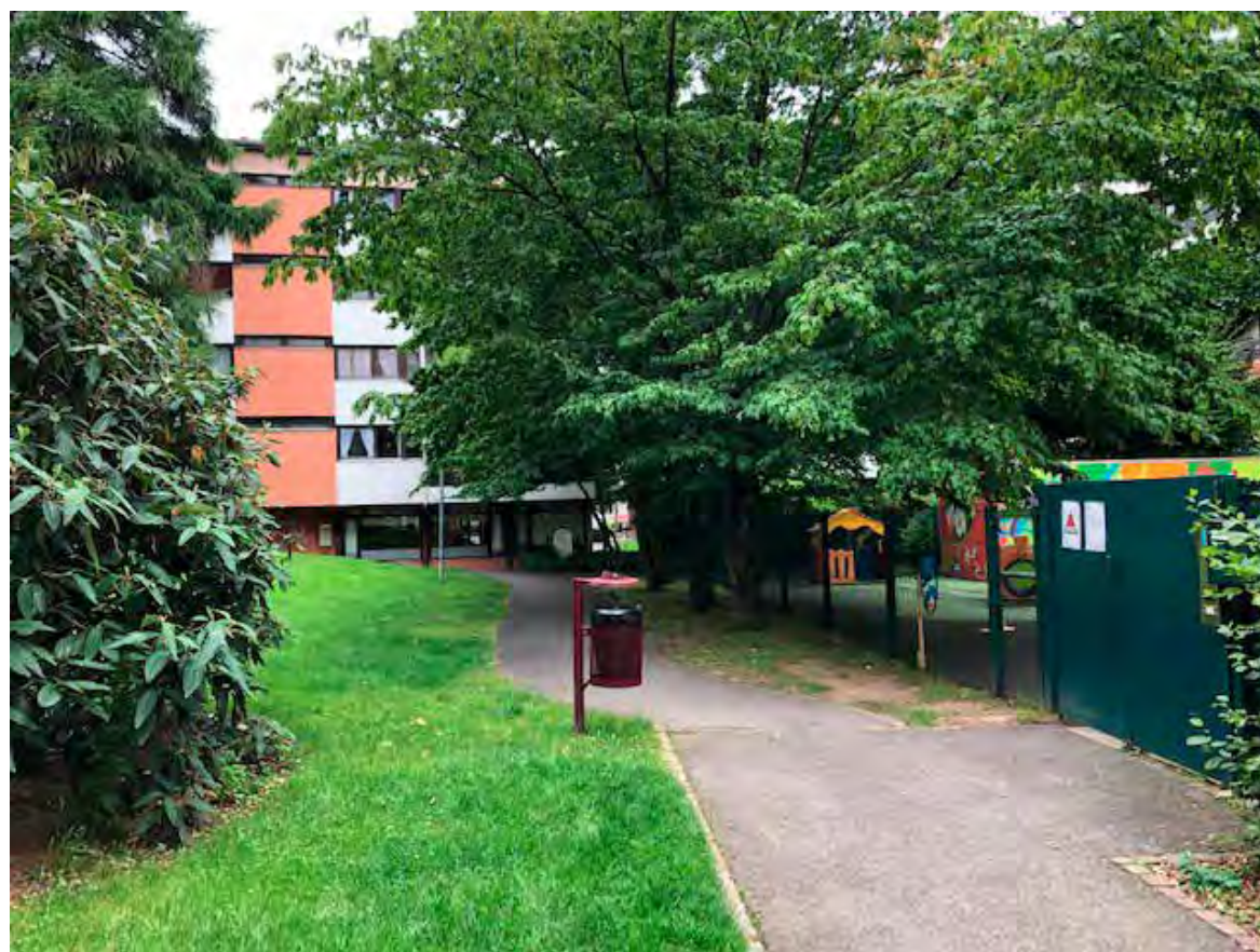
Exemple d'un cheminement piéton entre deux immeubles. © Ville de Thonon-les-Bains, 2018
